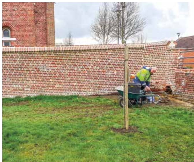
→ Jointoiment des murets d'enceinte du jardin du presbytère.
