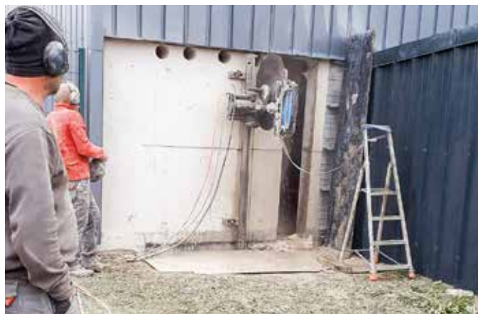
→ Salle de sports : création d'une issue de secours supplémentaire.
