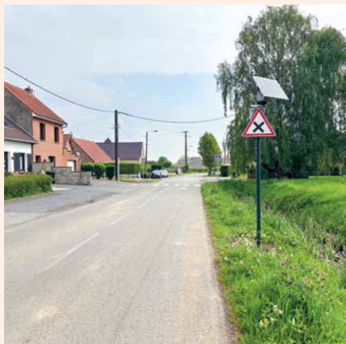
→ Installation d'un panneau clignotant lumineux à Leds de priorité à droite et d'un marquage au sol.
