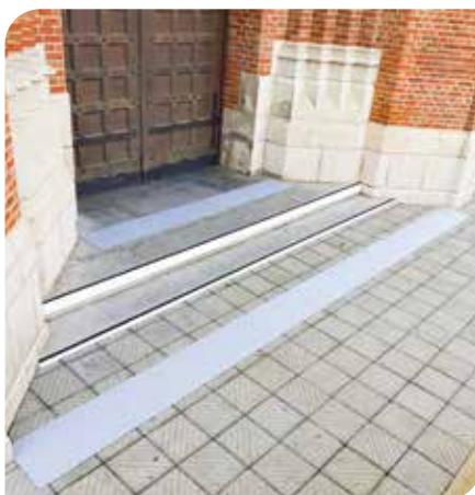
→ Pose de dalles podotactiles et nez de marche antidérapant devant l'entrée principale de l'église St Barthélémy.
