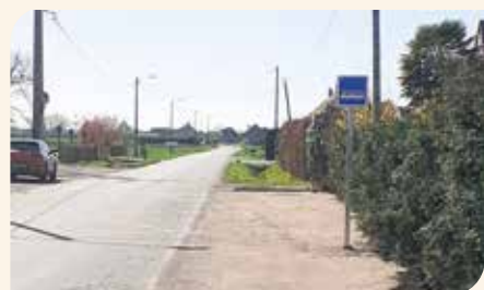
→ Déplacement, aménagement et sécurisation de l'arrêt de bus, rue de Merville.
